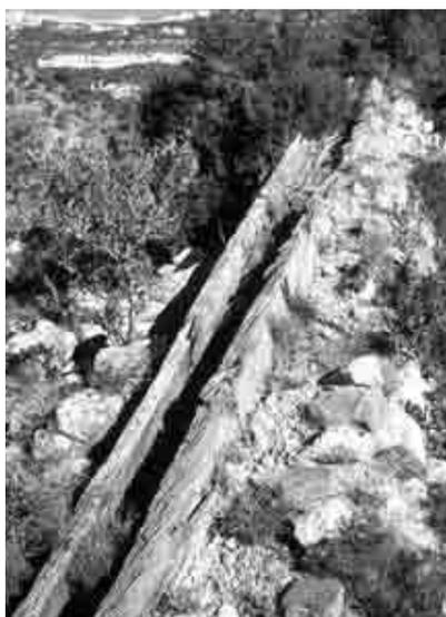
Un tronco ahuecado transporta el agua del canal al molino. La inclinación del terreno facilitó el trabajo. (Lacabazonada, 2011)
