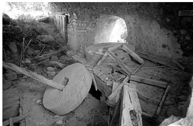
Molino harinero: la bancada con dos parejas de piedras de moler y restos de caballete y tolva — 2006
