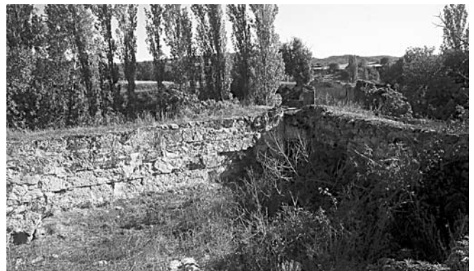
Embalse: grandes piedras forman paredes que rematan en cono hasta un amplio saetín; detrás se pueden ver los edificios. — 2006
