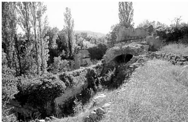
Lado oriental: a la derecha la boveda de cañon del harinero. A la izquierda: en primer plano la entrada del aceitero y al fondo la parte inferior de la central eléctrica — 2006
