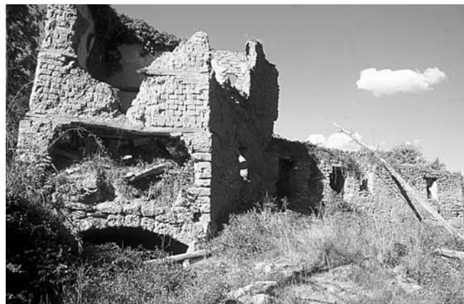
Lado meridional: delante, el desagüe de la central eléctrica. A la derecha, el molino aceitero — 2006
