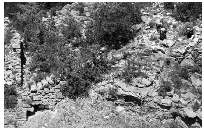
Canal y piedras para las puertas — 2015
