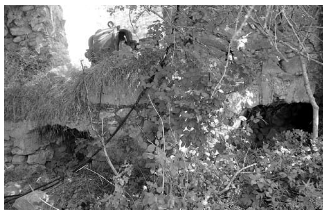
La central y el harinero; cada cual con su desagüe
