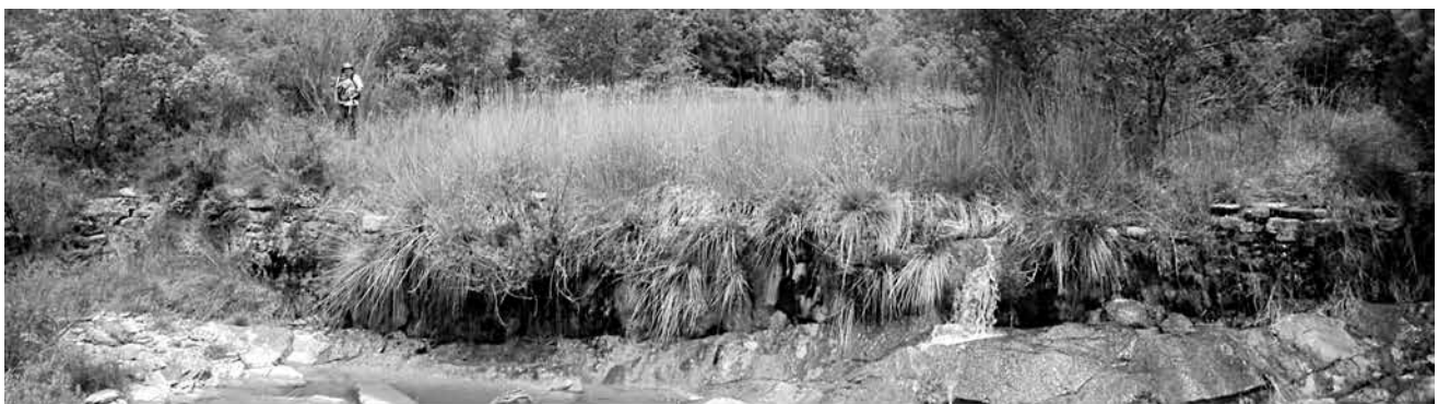
Azud recto de mampostería
