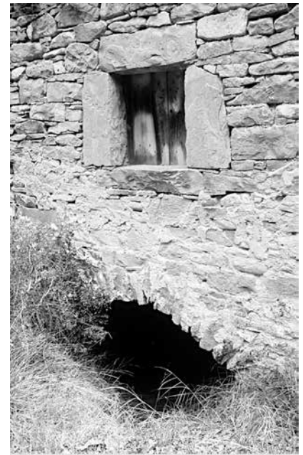
Ventana sobre el cárcavo — 13
