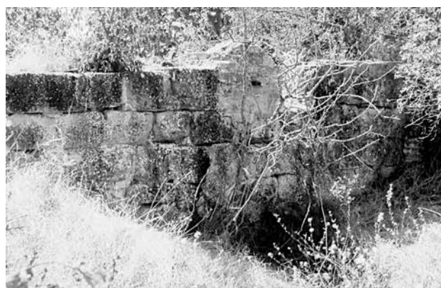
Muro de balsa (2Ⓛ) con aliviador (2Ⓞ) — 3
