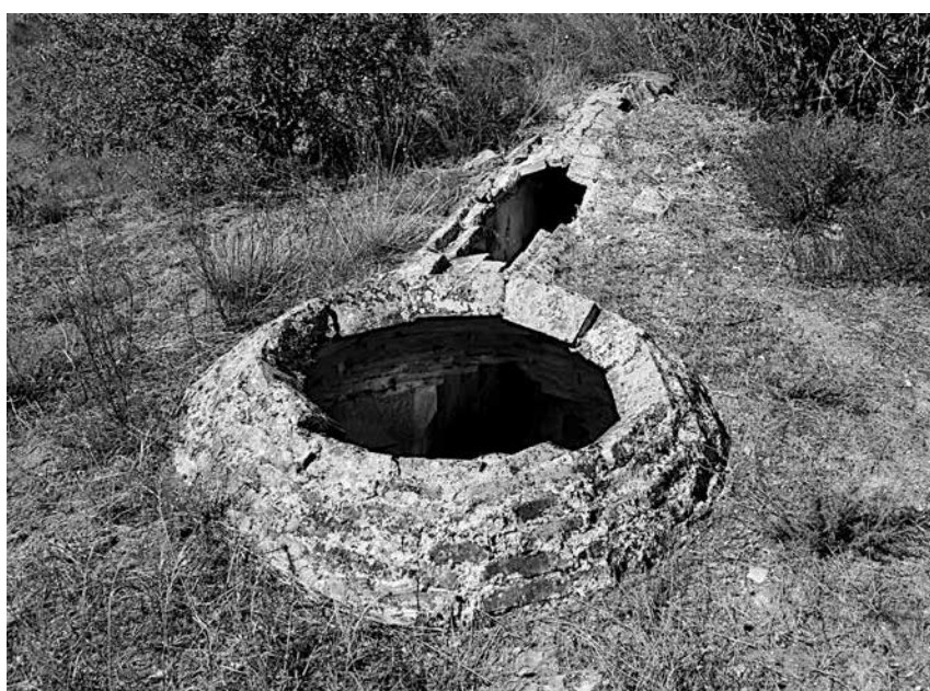
Molino de arriba: canal de piedra y cubo — 4
