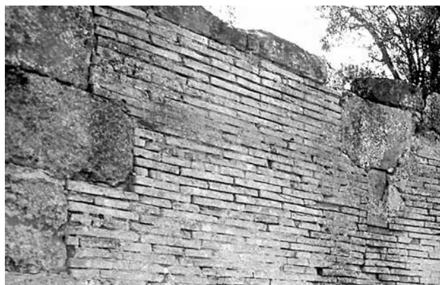
Molino de abajo: mampostería en el embalse — 11
